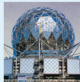
图1-15 某建筑的网壳结构
