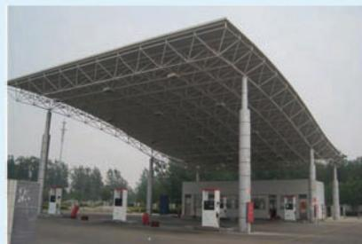
图1-14 加油站顶棚的网架结构
